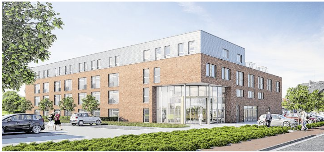
92 Pflegeplätze entstehen in dem neuen Seniorenzentrum.
